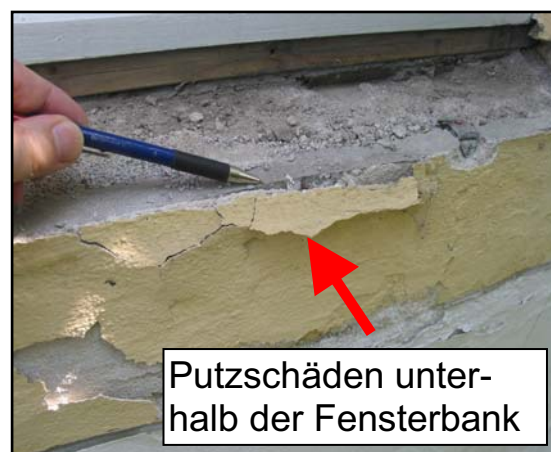
Abbildung 10: Ansicht der Brüstung nach Rückbau der Fensterbank.
