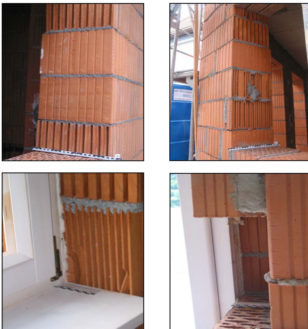
Abbildung 11 : Mangelhaft vorbereitete Leibungsflächen.
