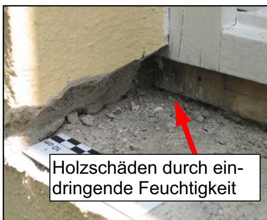
Abbildung 10: Ansicht der Brüstung nach Rückbau der Fensterbank.
