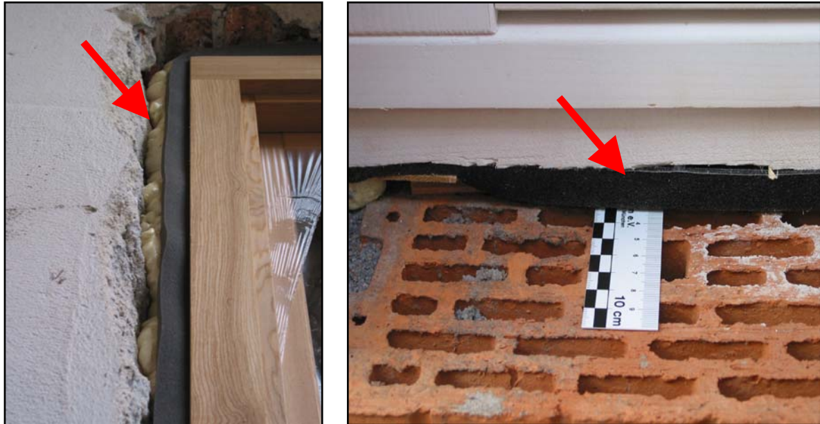
Abbildung 4 : Ungeeigneter Einsatz eines vorkomprimierten Fugendichtbandes.
