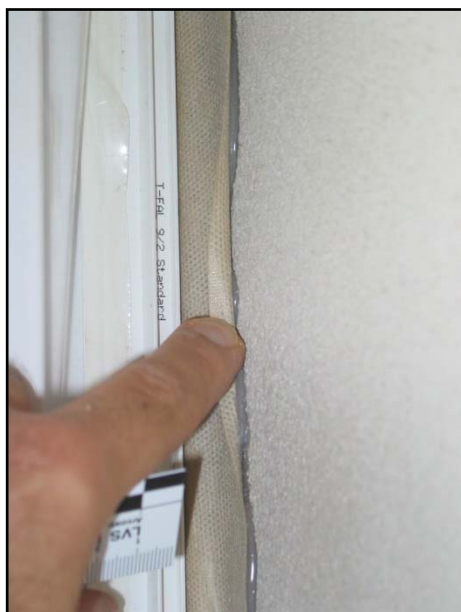
Abbildung 14: Beispielhaft dargestellte fachgerechte Fugenabdichtungen.
